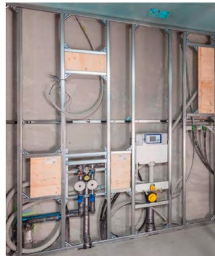
[FIG. 17] Système d'installation sanitaire de fabricants de systèmes complets.
