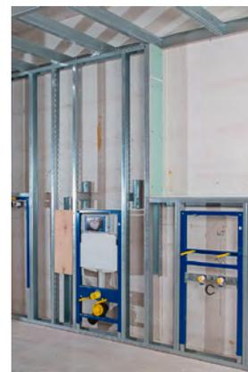
**[FIG. 15]** Élément sanitaire dans la cloison sèche avec fixation arrière par le constructeur à sec.
